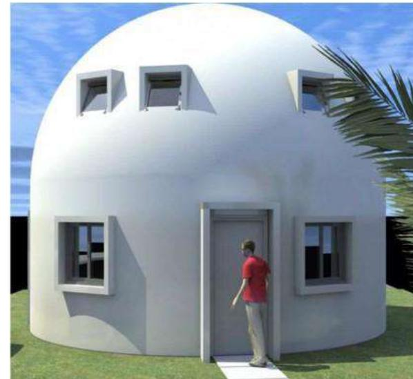
Izquierda. Casa con paredes en ferrocemento (Adaptado de "L. Robles- Austriaco et al. Ferrocement Floating House. International Ferrocement Information Center. Do It Yourself Series. Booklet Number 10. Bangkok, Thailand, 1991.). A la derecha, casa diseño especial con ferrocemento
